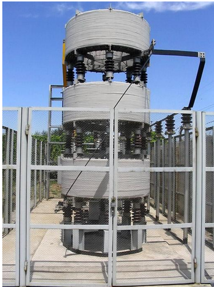
Рисунок 3-4 – Загальний вид фази бетонного реактора (а) і трифазний комплект реактора (б).
